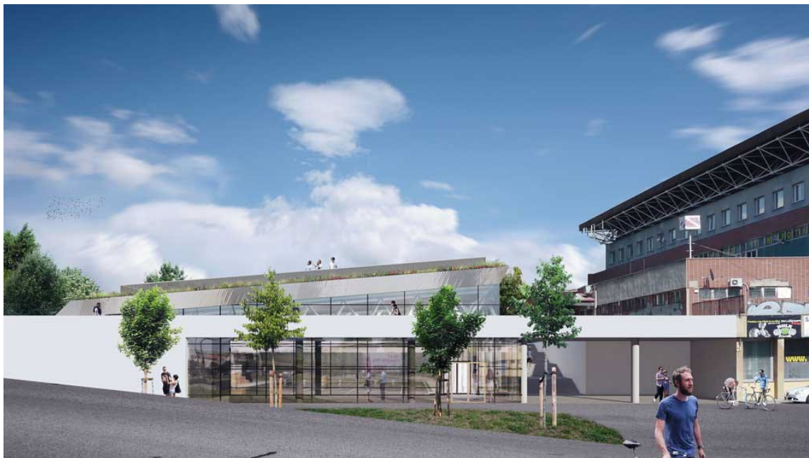
Obr. 25 – Dostavba městského plaveckého stadionu, Zdroj: bazenzaluzankami.starez.cz/
